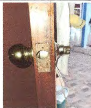
Foto 4: Sustitución de chapas
