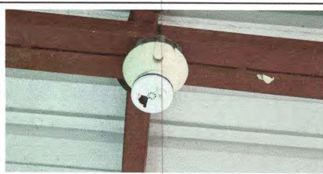
Foto 12: Sustitución de focos ahorradores
