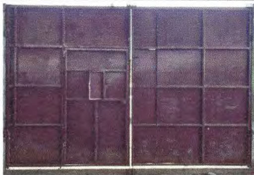
Foto 9: Mantenimiento a portón de metal
