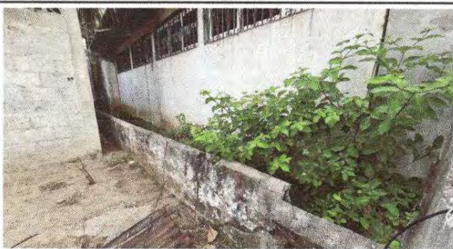
Foto 11: Reparación de muro perimetral de block
