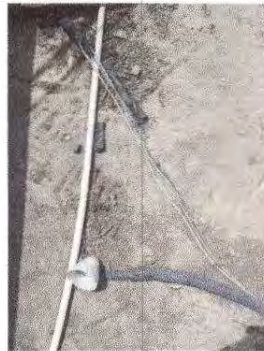
Foto 2: Reparación de pañuelo
