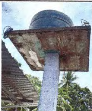
Foto13: Reparación de base de concreto para depósito de agua
