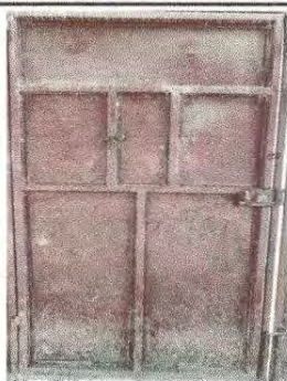
Foto 5: Sustitución de puertas
