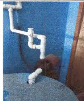
Foto 10: Sustitución de llave de cheque
