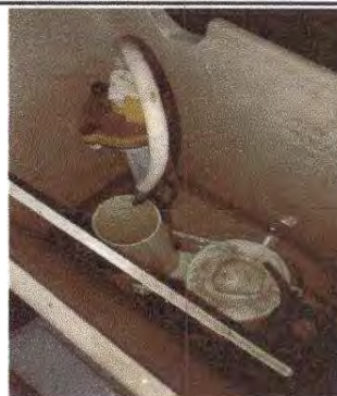
Foto 8: Sustitución de accesorios de inodoro
