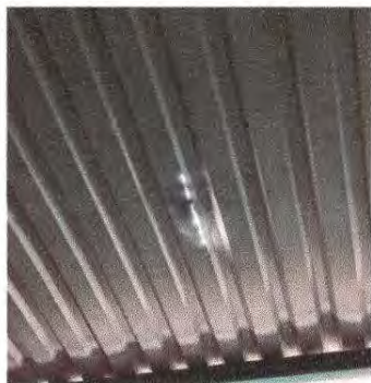
Foto1: Sustitución de lámina
